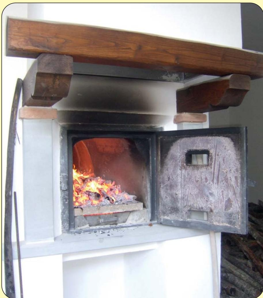
Fornacella laterale per il caricamento della legna, con griglia in ghisa e cassetto per la raccolta della cenere su forno con rivestimento in muratura
