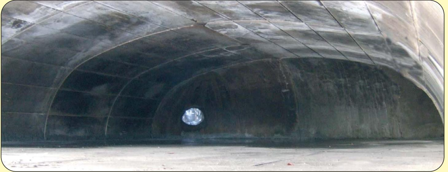
Vista interna della volta in refrattario del forno tipo 180
